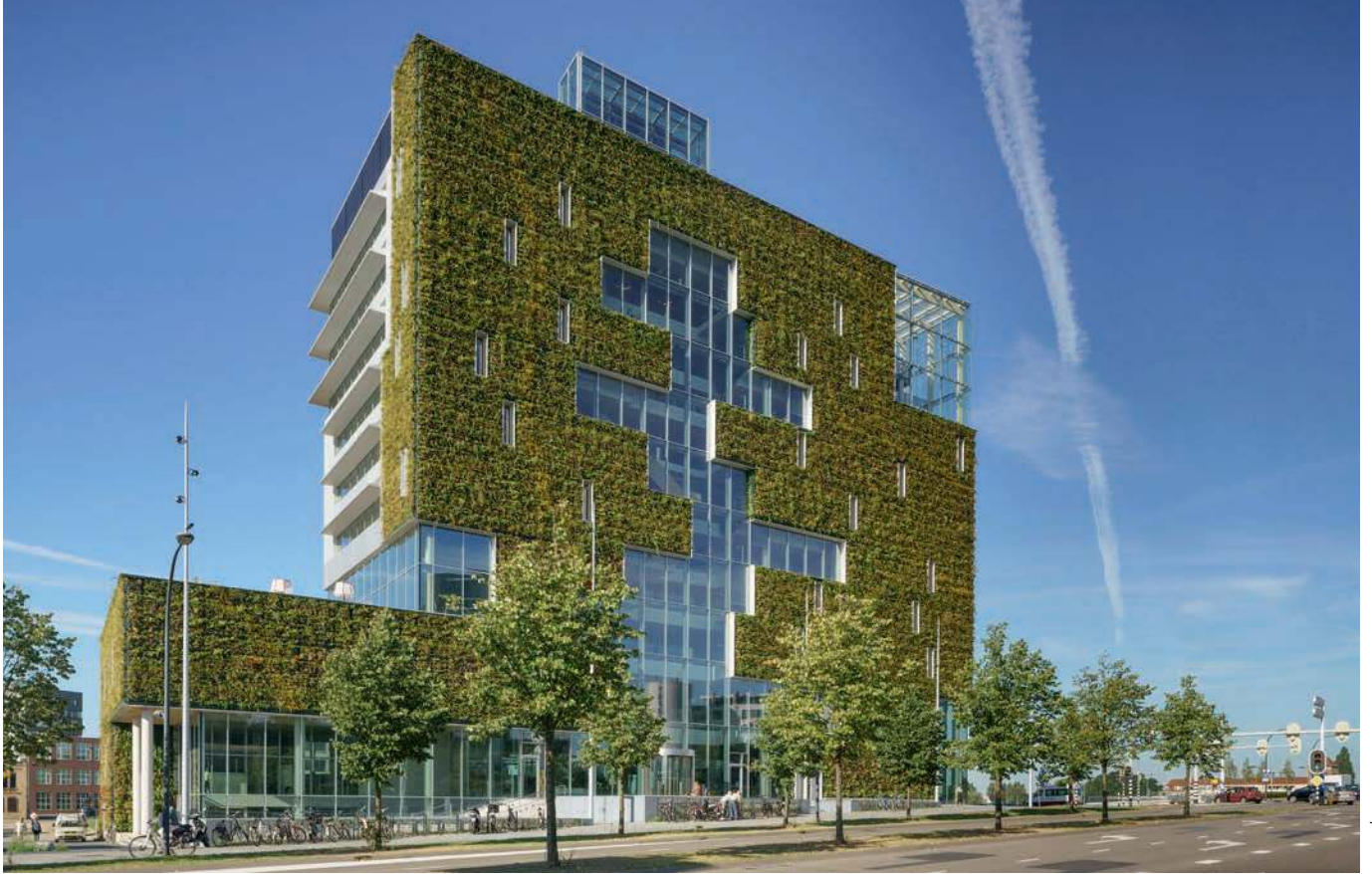
De verticale tuin van de noordgevel haalt de fijnstofproductie van 3.000 m 2 autoweg en 30% stikstof- en zwaveloxide uit de lucht.
